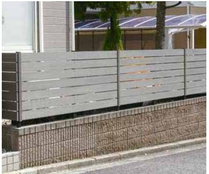
施工事例 千葉県 / M様邸 カラー:シルバーグレー
