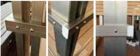
正面から見た納まり 正面(左)と側面(右)の納まり 側面の納まり
